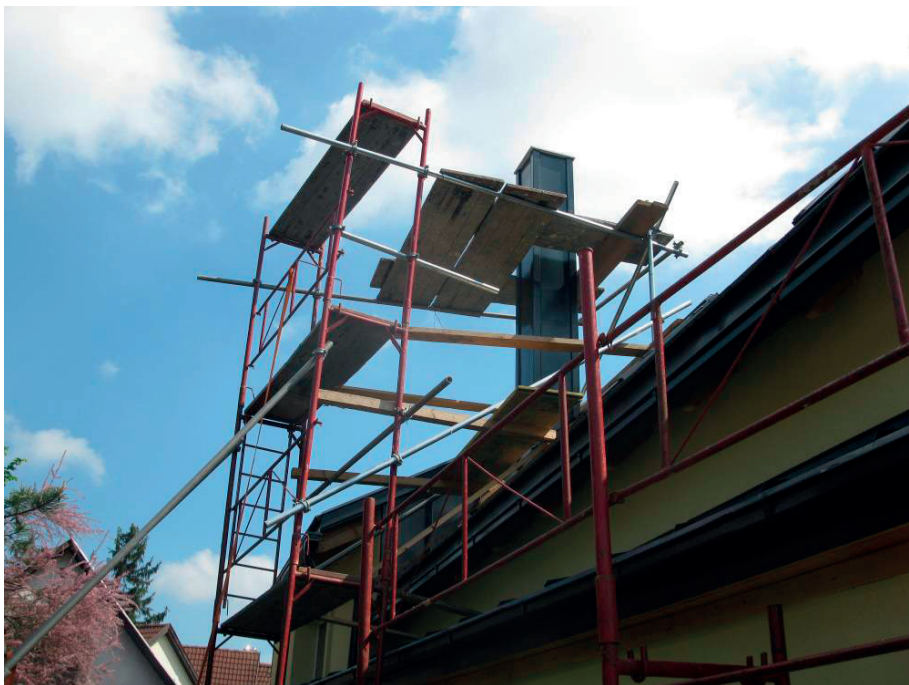
Építőipari célvizsgálat során készült fénykép egy szabálytalan kialakítású állványról
